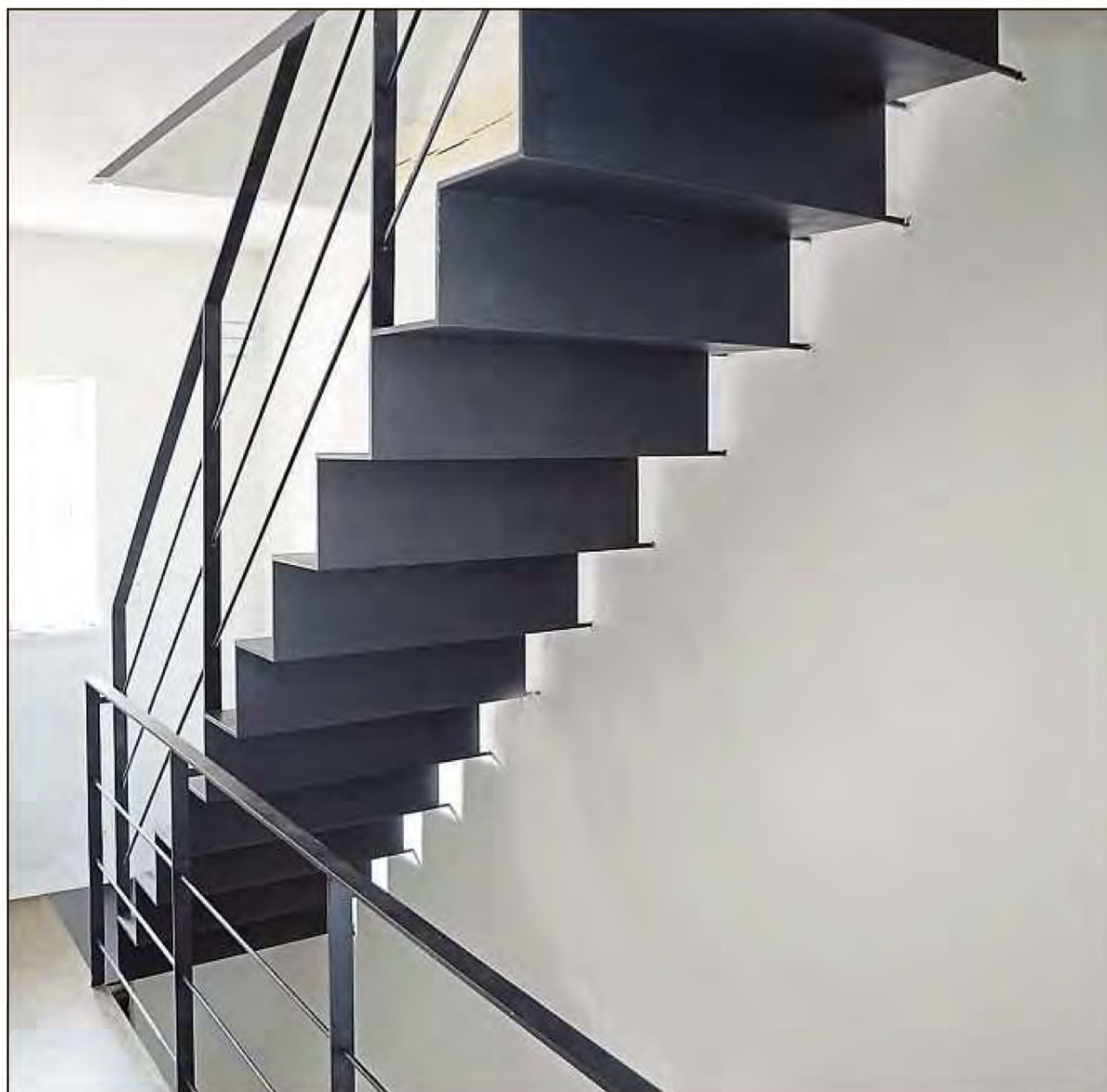
Die neue Treppe in zartem Grau.
