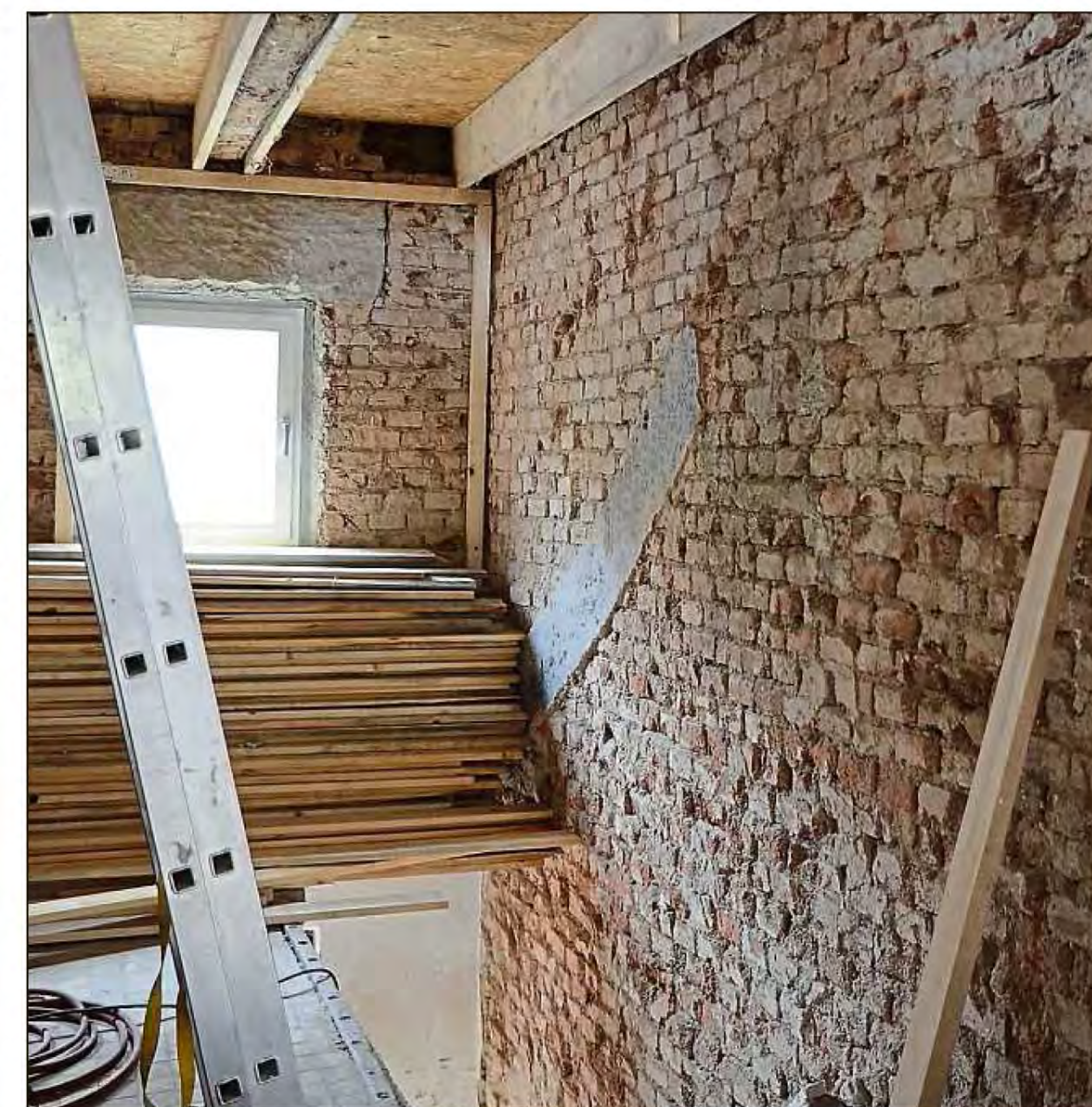
Der Treppenraum vorher.
